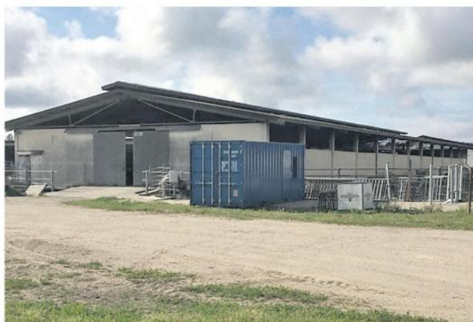
Il capannone che ha ospitato l'impianto sperimentale
